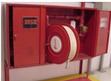
Figura 13 – Conjunto Mangotinho com Carretel e Esguicho Regulável, DN 25
