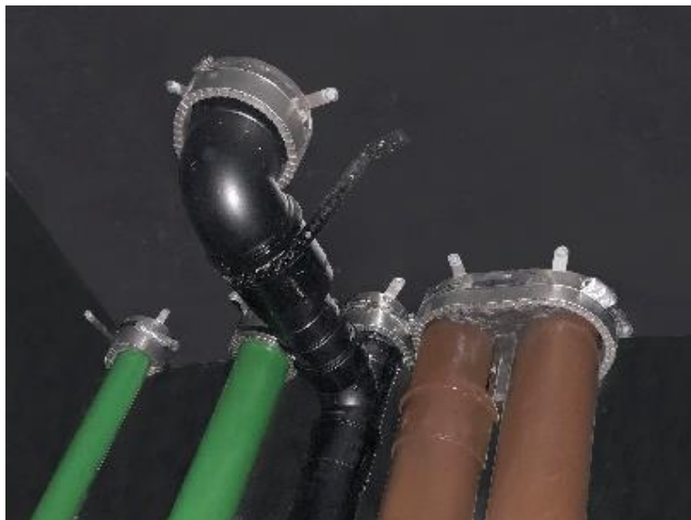
Figura 1 – Selagem Hidráulica – Exemplo de Proteção Passiva
