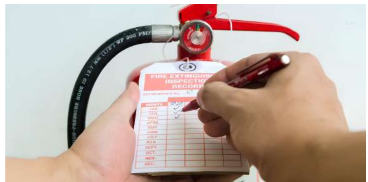
Rótulo de Registro de Inspección
