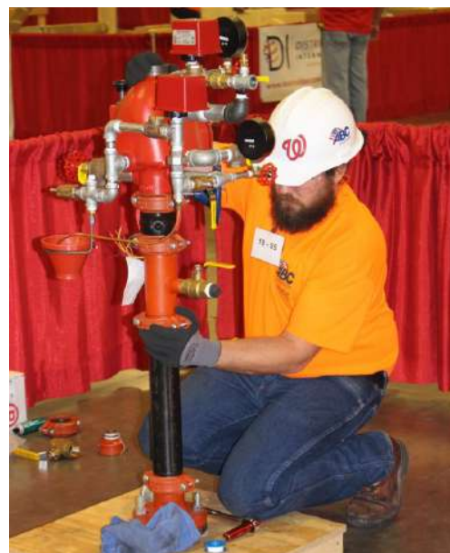
Entrenamiento de armado válvula sistema de rociadores
